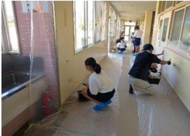
下地(現状の壁)との密着性を高めるために研磨布で塗装する面を研磨した後、水性塗料を刷毛とローラーを用いて2回塗装します。
